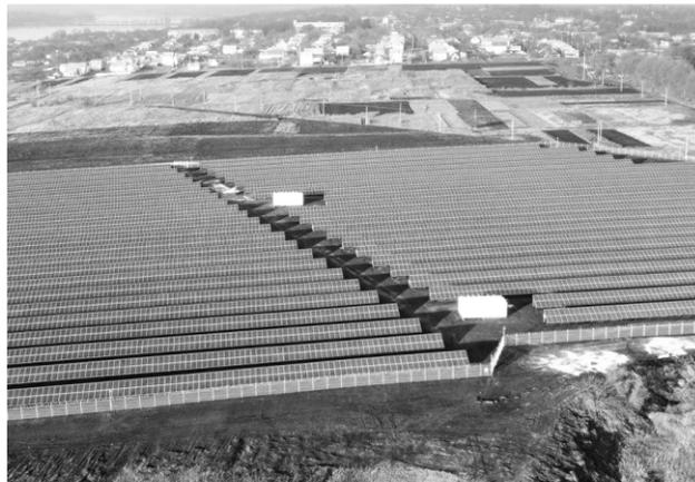
**1. Побудовано нове підприємство СЕС «Златопільська»**, яке займається виробництвом енергії із сонця. Сонячну електростанцію розміщено у північній частині, на ділянці площею 7,4109 га. Потужність станції – 4,718 МВт. Прогнозована річна генерація електроенергії – 5744 МВт-год/рік. Введення в дію нового підприємства (I черга) дало змогу створити 25 нових робочих місць, які до кінця 2020 року заплановано збільшити, побудувавши другу чергу підприємства.
